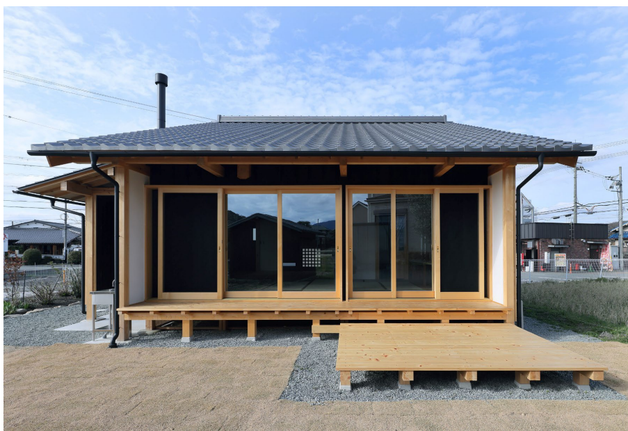
南側の開口部は延焼ラインから外し木製建具を製作した。北側は幹線道路が近く騒がしい。
