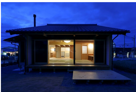
南側の開口部は延焼ラインから外し木製建具を製作した。北側は幹線道路が近く騒がしい。
