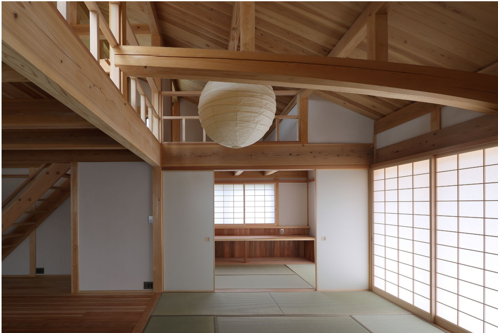
浴室を除いて、仕上げは杉・桧と左官屋オリジナル配合の砂漆喰壁。床・天井（化粧野地・荒野地）共に 30 mm 杉板を使用し、下地合板はゼロ。
