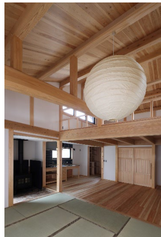
浴室を除いて、仕上げは杉・桧と左官屋オリジナル配合の砂漆喰壁。床・天井（化粧野地・荒野地）共に 30 mm 杉板を使用し、下地合板はゼロ。
