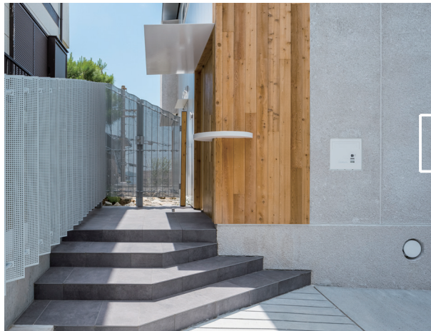
パンチングメタルのフェンスと木の外壁の間から玄関へ
