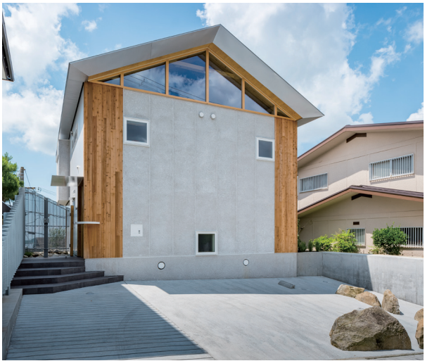
北側外観。駐車場には宅地造成時の名残の岩を再利用
