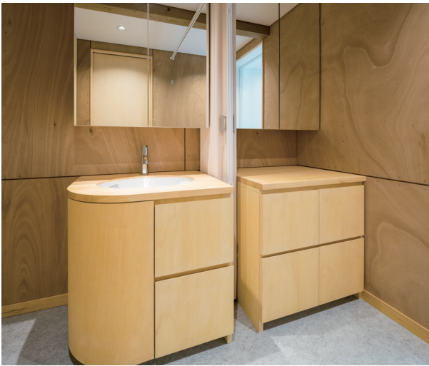
壁の構造用ラワン合板と家具のシナ合板のコントラスト
