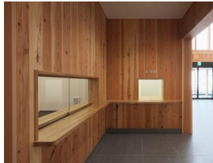
羽目材張り仕上げで木の温もりを感じる
