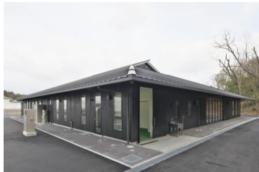
軒を2m出し羽目板を保護する
