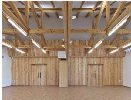
トラス構造を現しとし天井高さを強調した会議室
