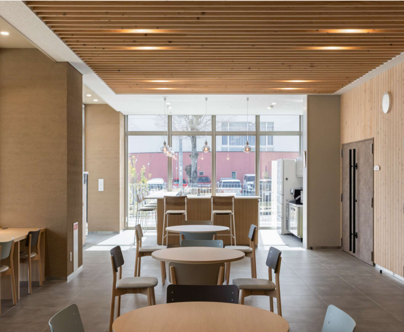
交流スペース・壁羽目板・天井準不燃ルーバー
