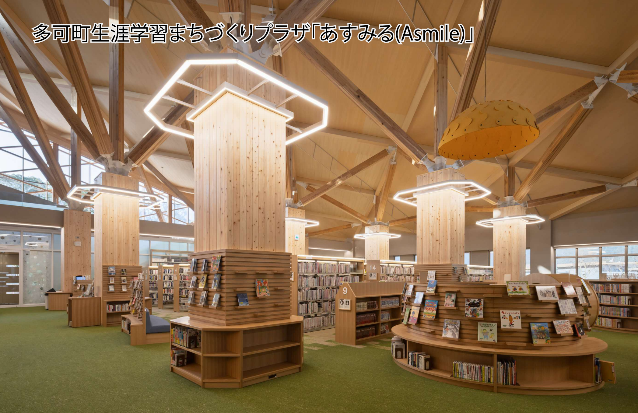
木造小屋組みの図書館
