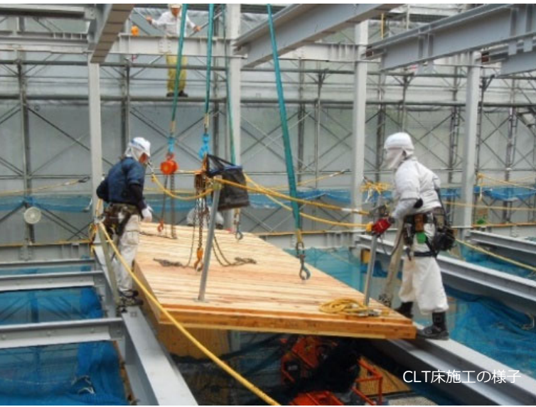
1フロア1～2日で早期に安定した作業床を構築可能
