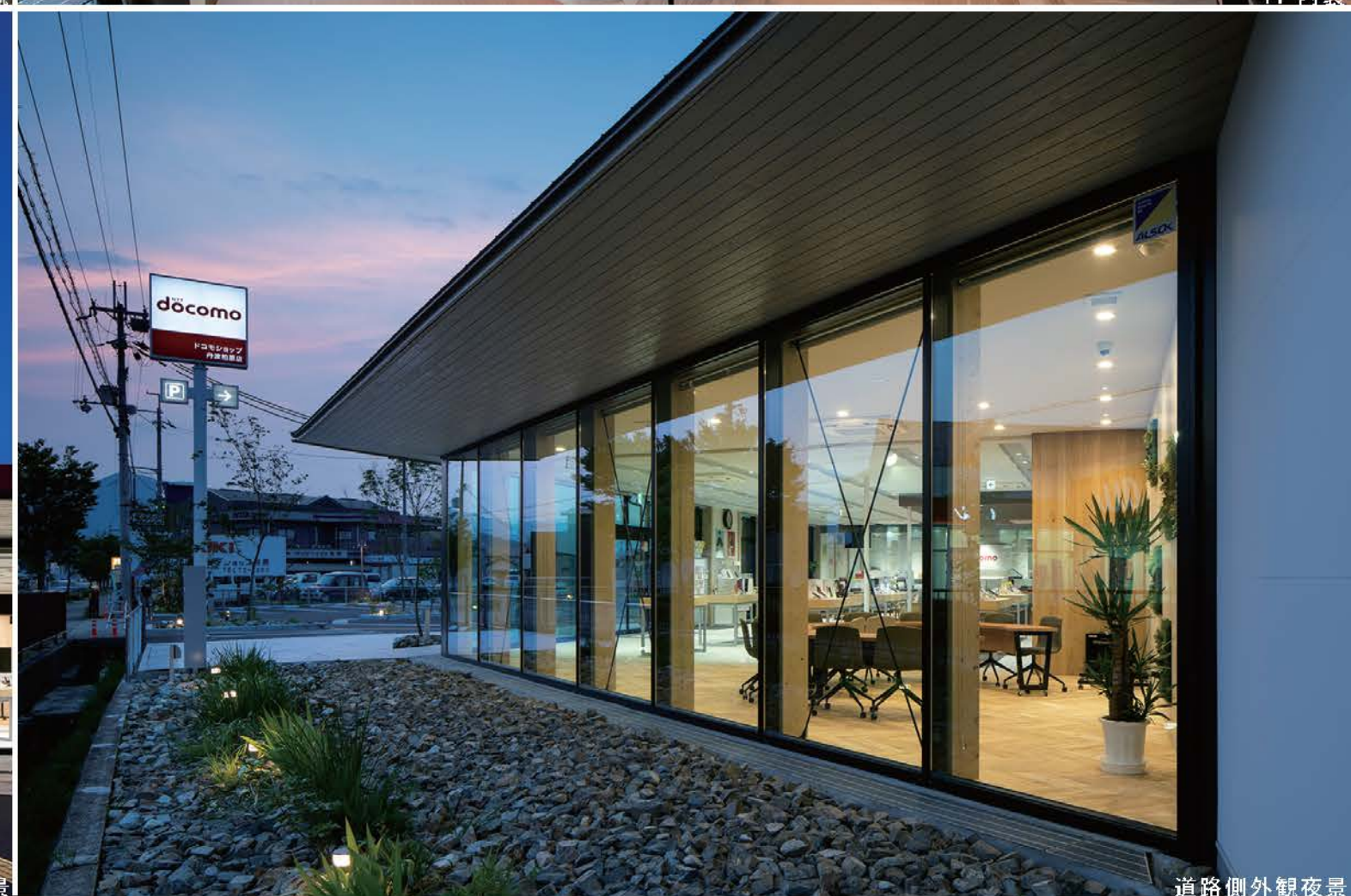
道路側外観夜景
