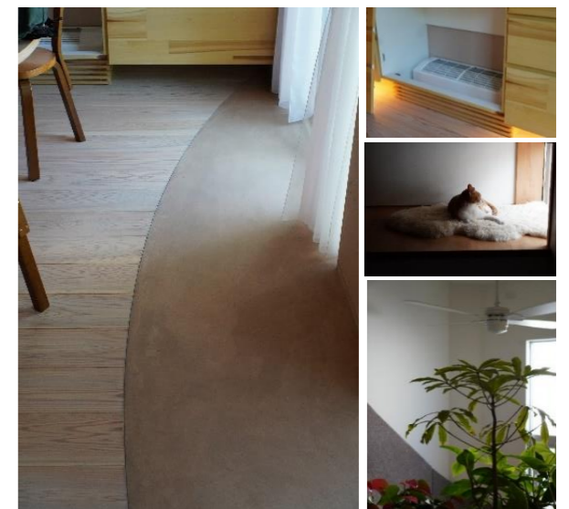
性能面では断熱改修を実施、1.2階メゾネットを生かして布基礎部分にコンクリートを施工し、床下エアコンを設置。左画像は南窓よりの直射日光を蓄熱するカラーコンクリートを施工。▼
