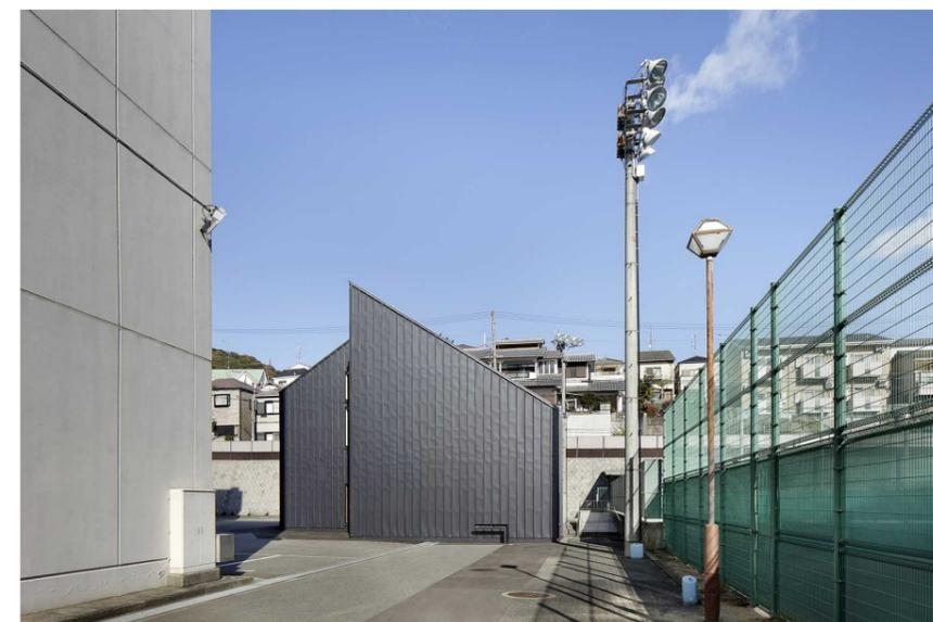
元々は駐車場として使われていた、キャンパス最奥部のひっそりとしたスペースが建設地です。白いRC造の既存校舎群の中で卒業生や在学生のための集いの場として、小さいながらも象徴性を表すために、外壁はリブ付黒色の金属製、屋根はシンプルな切妻形状にしています。
