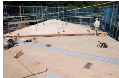
建方・接合の様子
